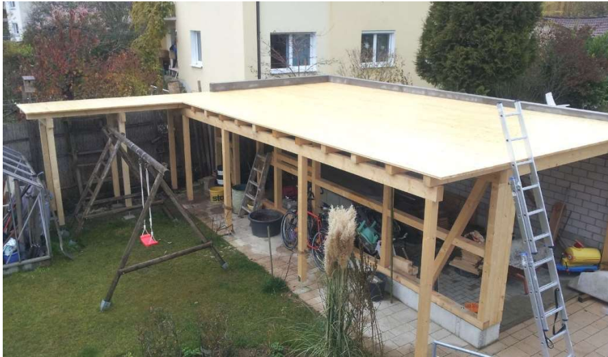
November 2016: Garagendach im Rohbau
