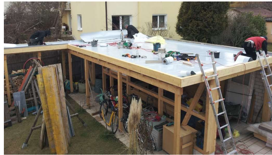
Februar 2017: Dachabdichtung durch Fachfirma mit ALWITRA EVALON Kunststoffdachbahn 1,5 mm
